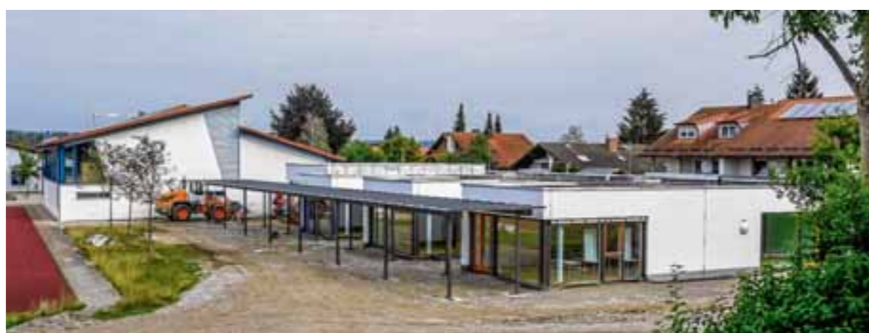
Ab September werden in dem neu gebauten städtischen Hort in Thalhofen 75 Kinder betreut. Für Ende Oktober, Anfang November ist die Einweihungsfeier geplant.
